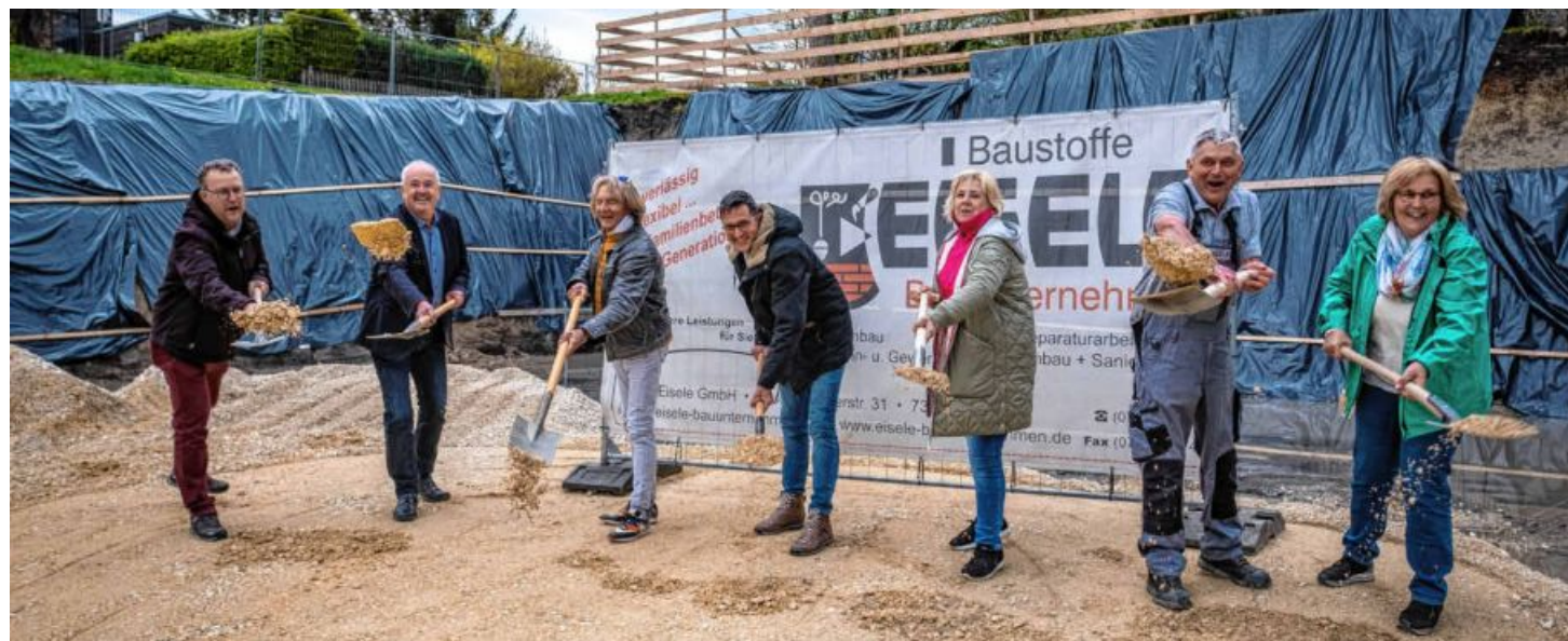
Der alte Kindergarten ist abgerissen, die Baugrube ausgehoben: Nun kann der Neubau des Gemeindehauses beginnen. Umgesetzt werden die Arbeiten von der Heinz Eisele GmbH. In ein bis zwei Jahren könnte das Projekt abgeschlossen sein. Foto: Oliver Giers
